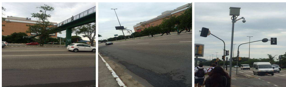
Figura 09: Passarela para pedestres e equipamento de controle da SSP.
