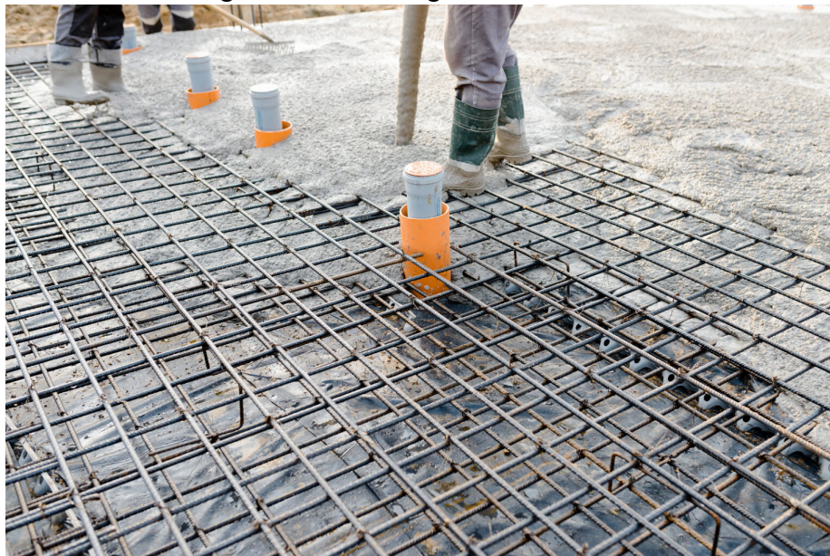
Figura 8 – Concretagem de um PCAC.
