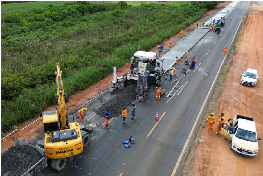
Figura 11 – Foto de uma obra de restauração de pavimento com WT .
