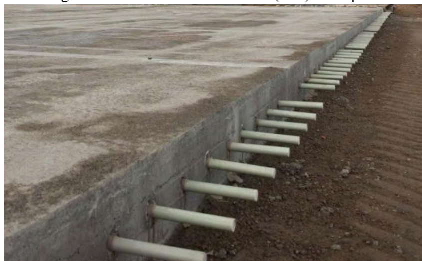
Figura 6 – Barras de Transferência (BTs) em espera.
