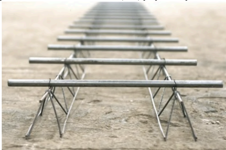
Figura 5 – Barras de Transferência (BTs) preparadas para a locação.
