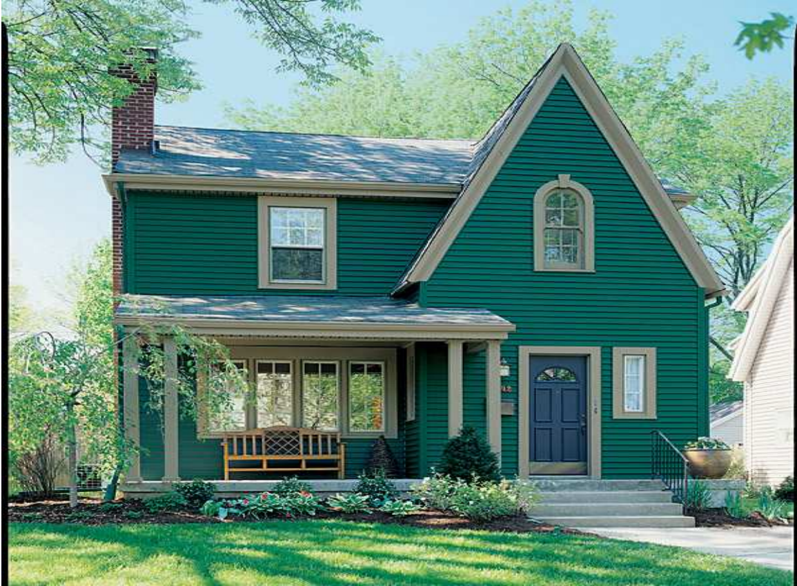
Figura 29 – Aplicação horizontal do siding vinílico Fonte: Vinyl Siding Institute, 2008.
