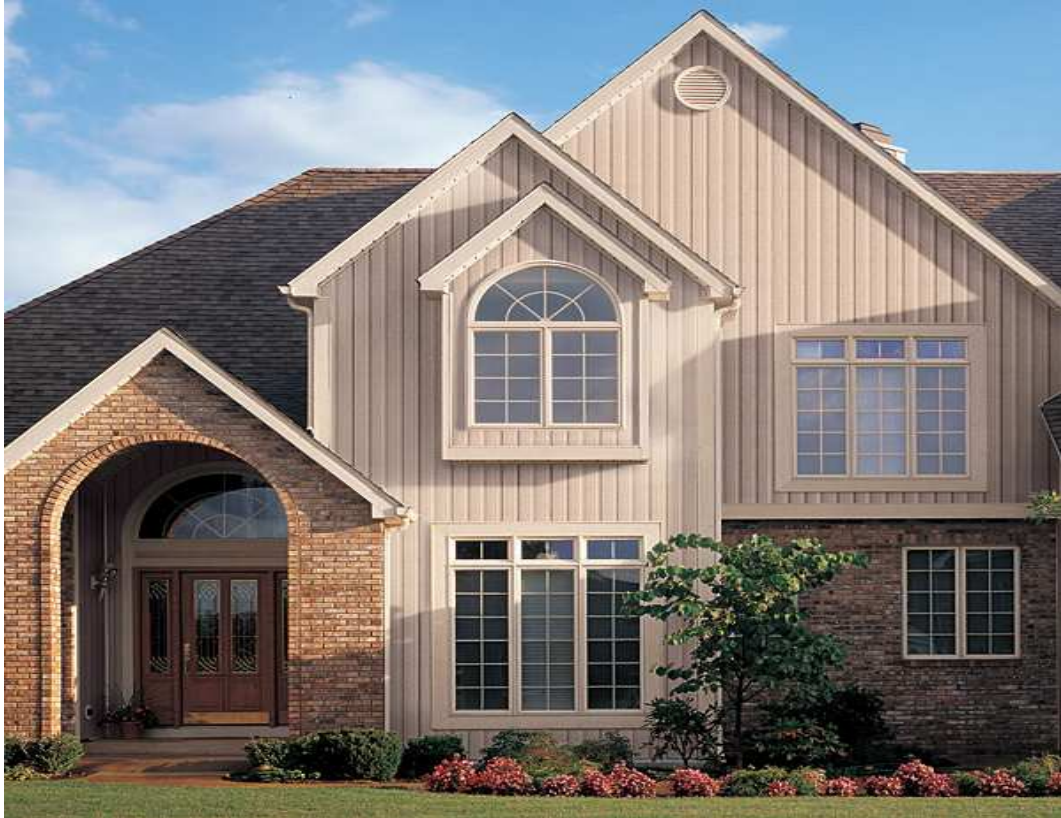
Figura 31 – Aplicação vertical do siding vinílico Fonte: Vinyl Siding Institute, 2008.
