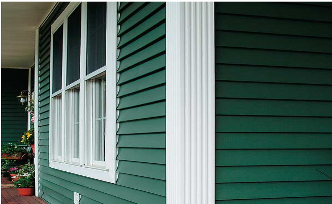
Figura 30 – Aplicação horizontal do siding vinílico Fonte: Vinyl Siding Institute, 2008.
