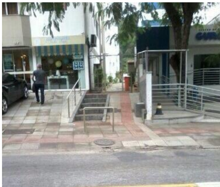
Figura 18 – Acesso duplo calçada e rampa Fonte: arquivos da autora – Junho de 2015
